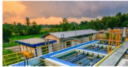
WTP Cidanau 600 lps
